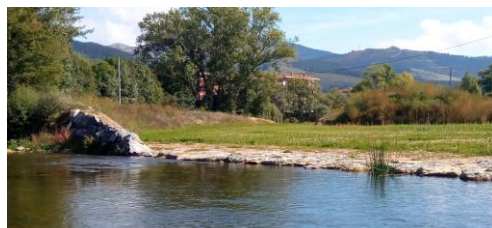
Entrada a cauce de avenidas
