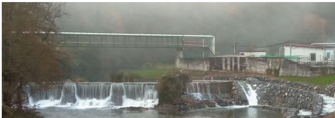
Rampa de peces en margen izquierda junto al azud
