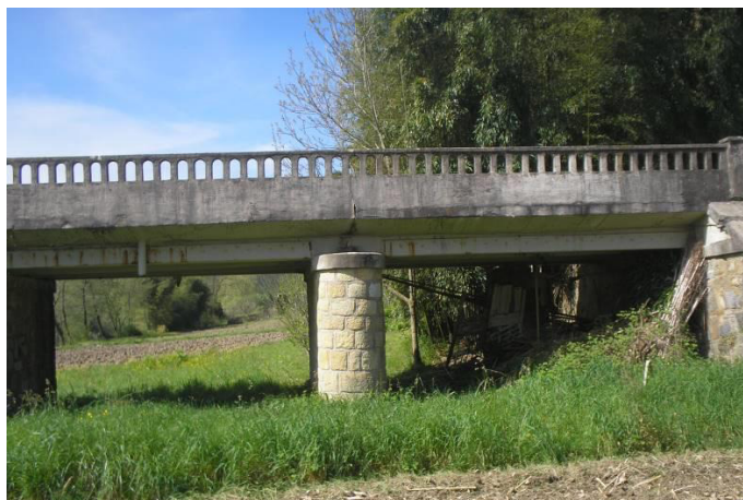
Vista de la zona de cruce bajo el puente Altzona
