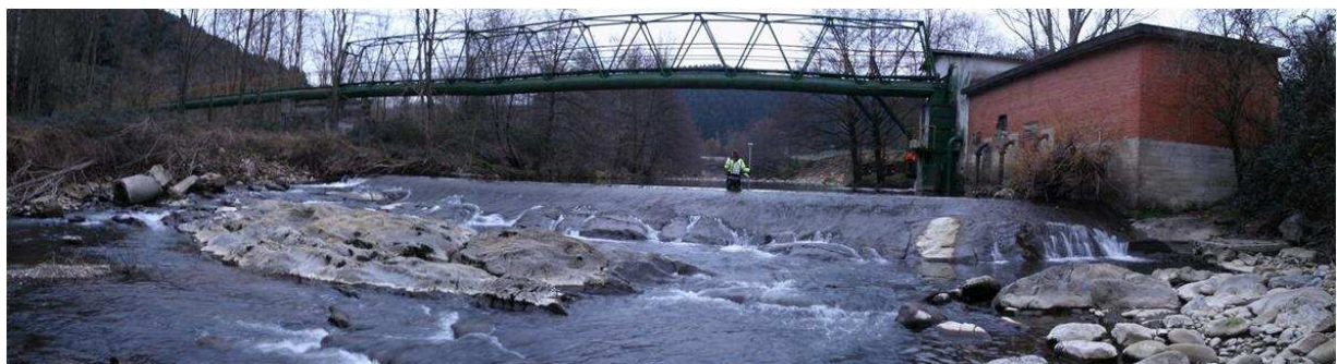
Presa txiki baten karakterizaziorako topografia-lanak
